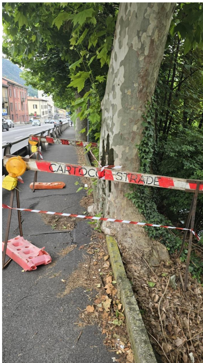
Figura 3 - particolare del piede dell'albero che ha inglobato il cordolo con la crescita diametrica del colletto.
