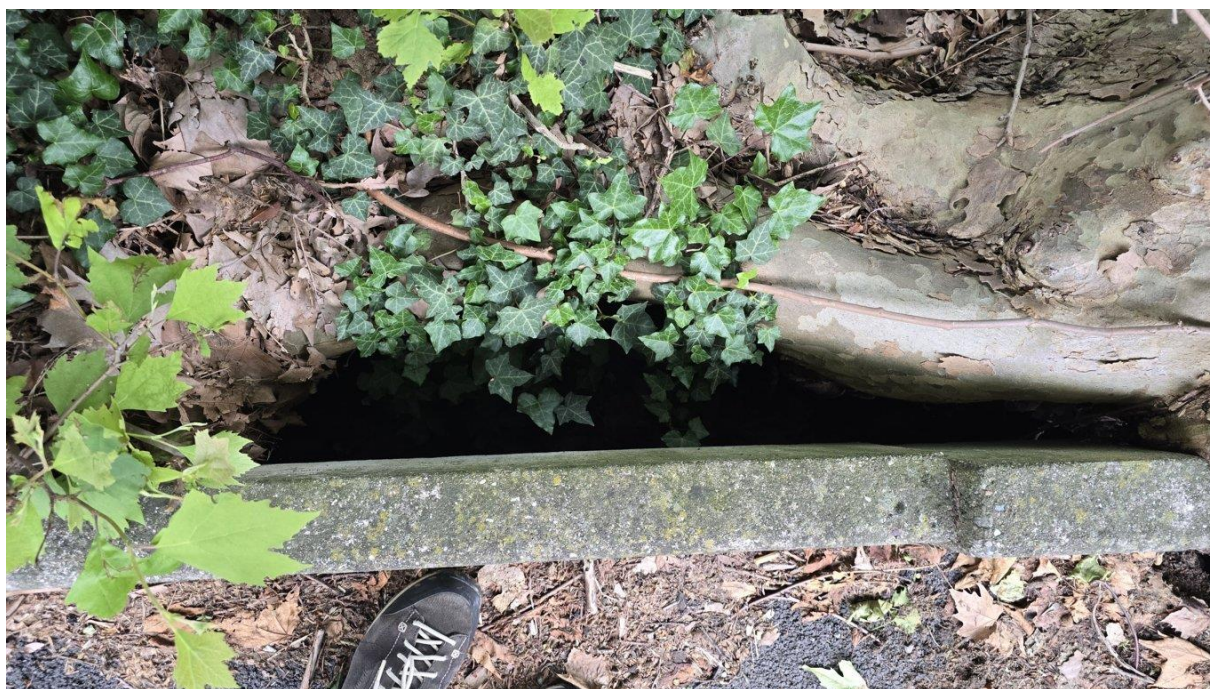
Figura 5 – particolare dello stacco dal cordolo e della profonda cavità.
