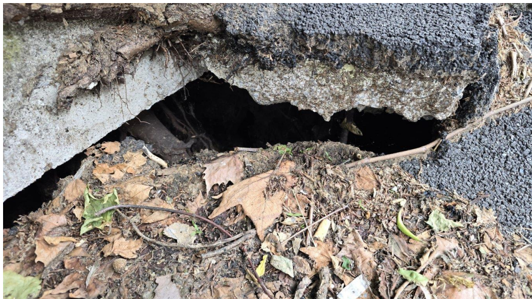
Figura 6 - spaccatura e stacco dei livelli del marciapiede; da qui penetrerà l'acqua raccolta da monte che infiltrandosi toglie terreno alle radici.
