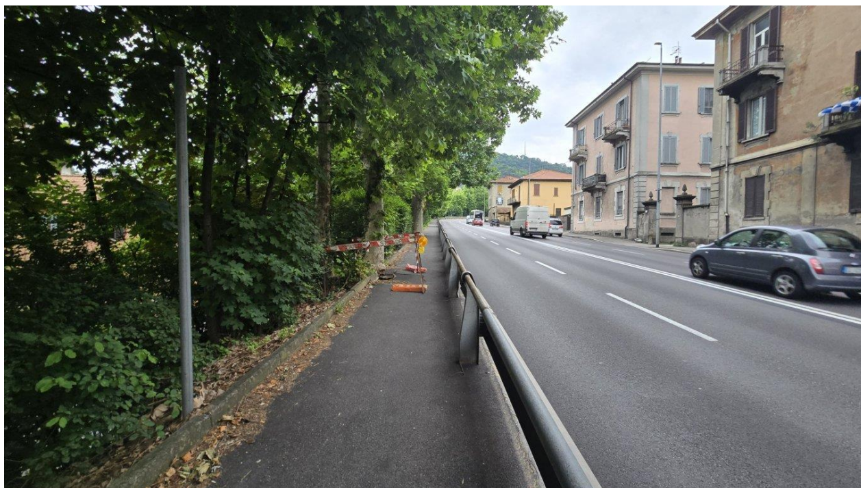
Figura 1 - l'area vista salendo la Via Napoleona è sulla sinistra ed interessa il marciapiede. Si è verificato uno svuotamento del sottofondo del marciapiede in corrispondenza del punto di radicazione in scarpata di due alberi (uno censito e l'altro no).
